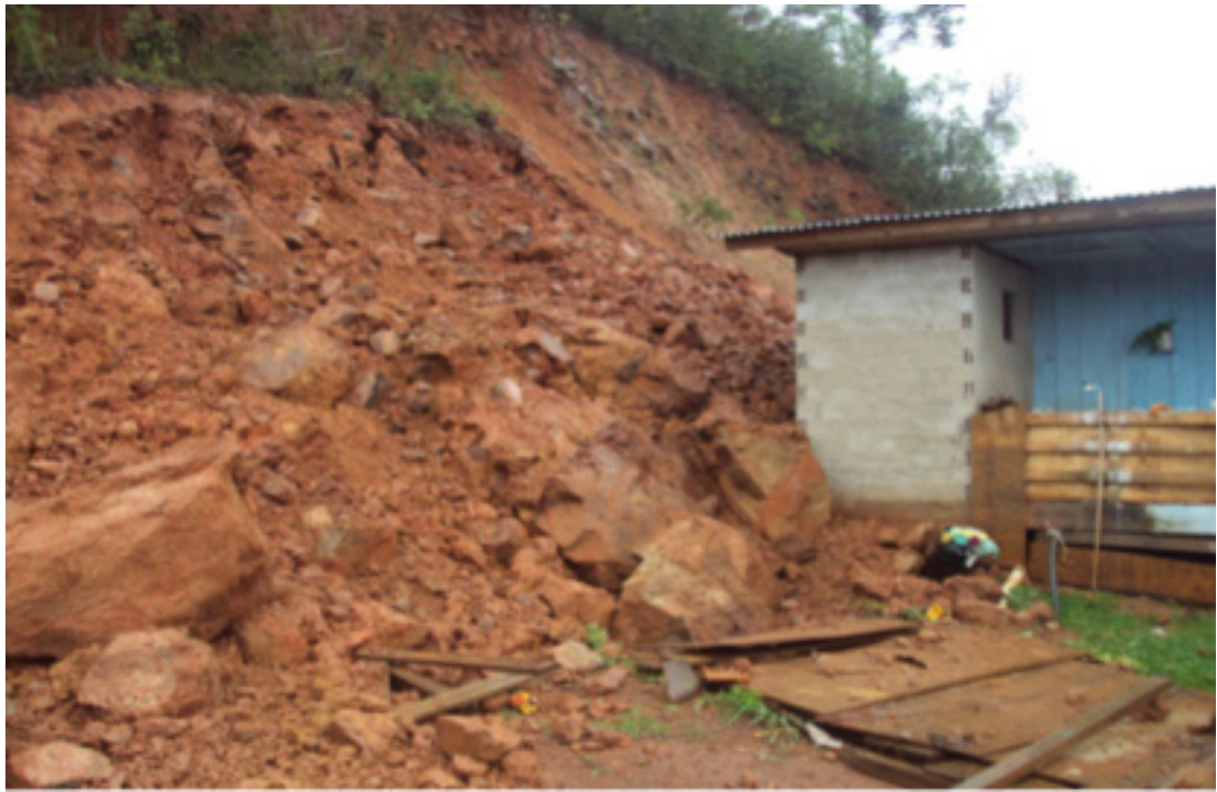
Figura 5-39 - Deslizamento induzido em talude de corte, no município de Francisco Beltrão.
